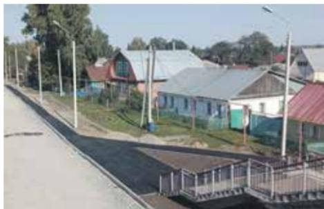
Подрядчик приступил к укладке асфальта на пешеходные тротуары, установке фонарных столбов и прокладыванию кабеля питания уличного освещения.
